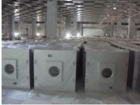
FFU 现场搁置
